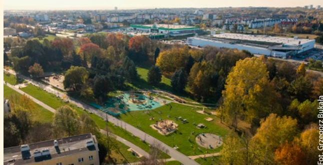
Na osiedlu Kmity
